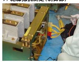
制御部の絶縁抵抗を測定いたします。
