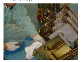
絶縁部・導電部・制御部・機構部などの ------埃や汚れの清掃を行います。
